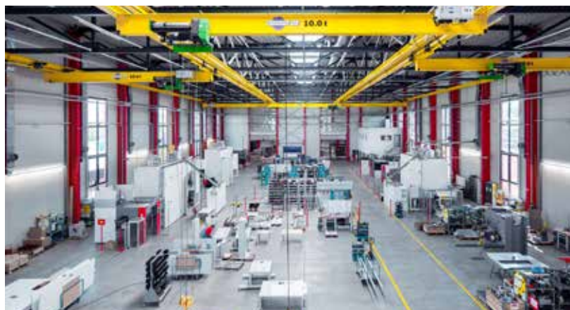
Alles aus einer Hand – für den Kunden schlüsselfertig erstellte Produktionshalle
