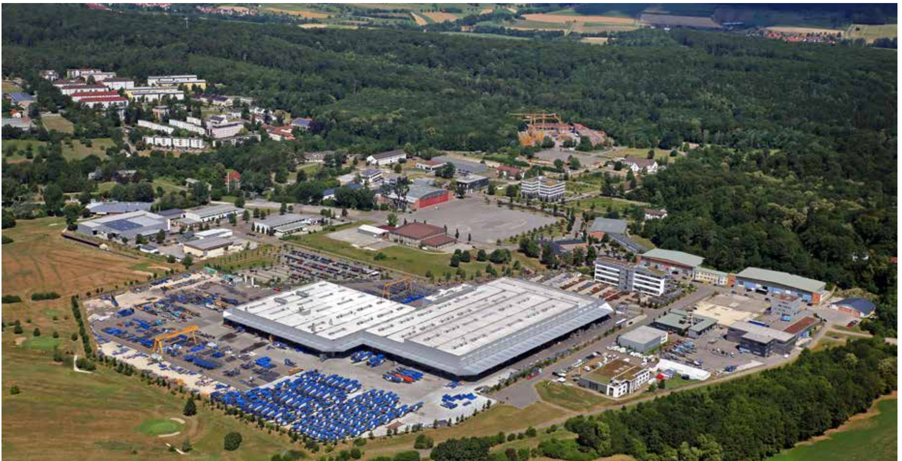
Gewerbegebiet Stauferpark in Göppingen
