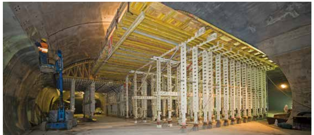
Der Gmünder Einhorn-Tunnel, bekannt geworden als „Bud Spencer-Tunnel“
